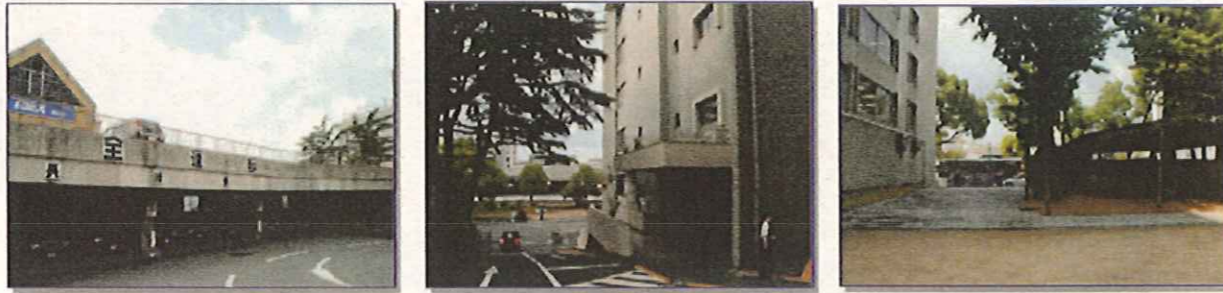
公用車庫(第一車庫)
