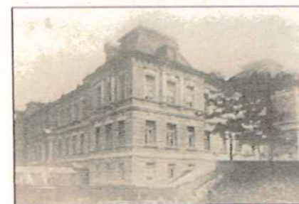
長崎港から見た県庁舎
