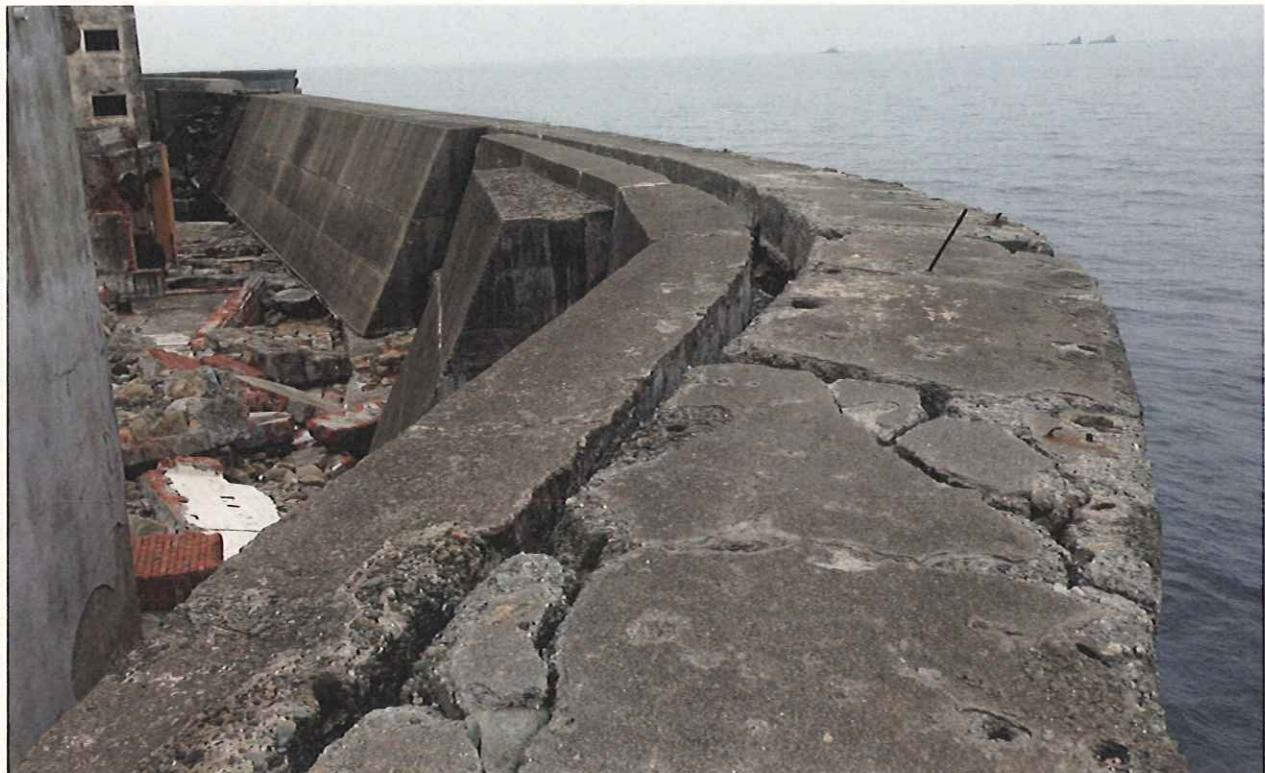
護岸が外洋側に前傾しており、上部の亀裂が進行している。
