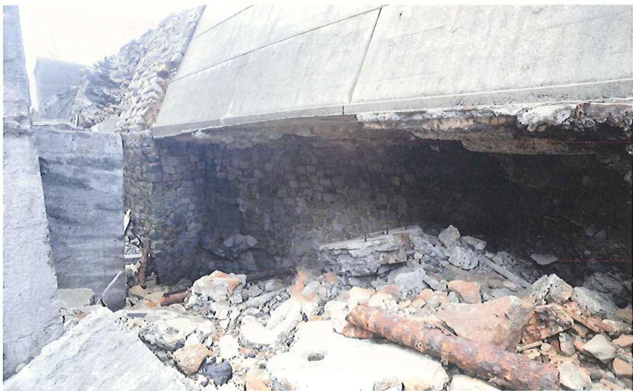
護岸の基礎部分が波による吸出しで流失し、大きな空隙となっている箇所 (L=33m、W=3m、D=1.5~5m)。
