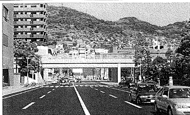
J R長崎本線連続立体交差事業 (梁川橋踏切付近 完成予想図)
