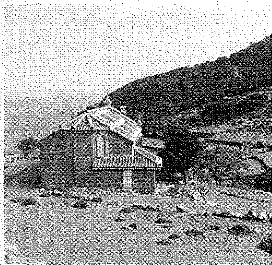
「旧野首教会」現在は無人島となっている小値賀町野崎島に建つ煉瓦造の教会堂(1908年竣工)
