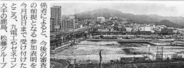
JR長崎駅西側で建設が予定される新駅舎とMICE複合施設の予定地 11月19日、長崎市
